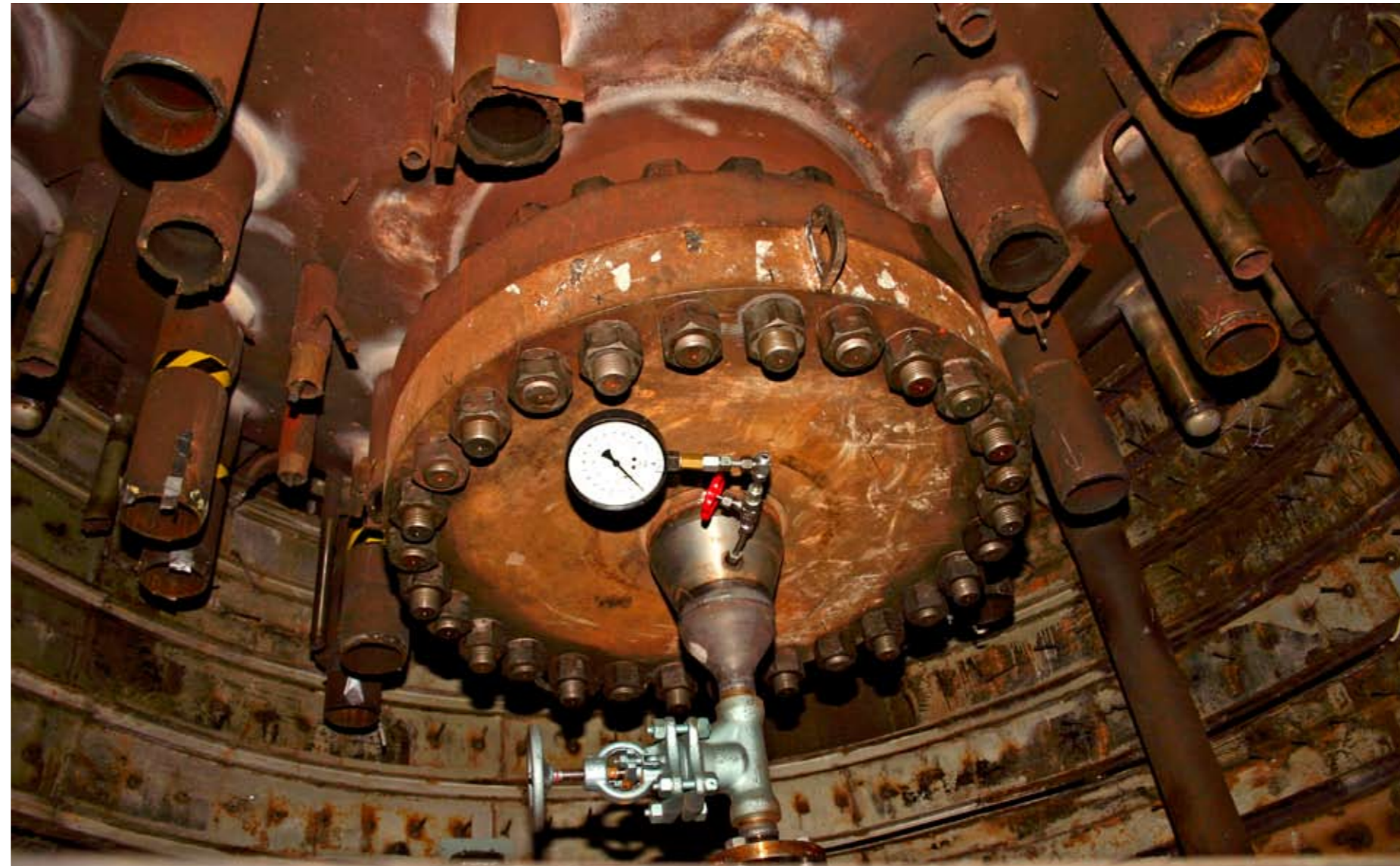
Figuren visar delar av reaktortankens botten som modifierades något för att kunna genomföra de termohydrauliska experiment som följde efter nerläggningen av Marviken.
